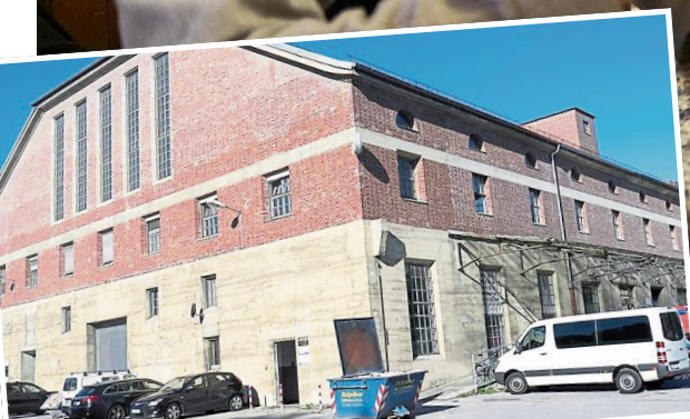
Die ehemalige Materiallagerhalle der Stadtwerke.
